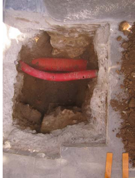
2. Mur UE 4 localitzat al sondeig 1.
