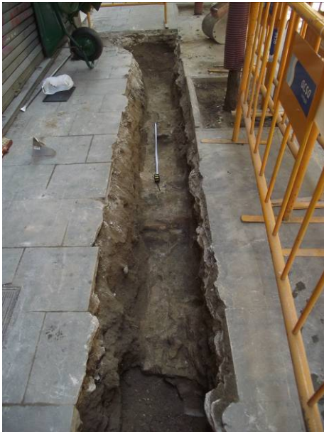
19. Mur UE 5 front la finca núm. 23.
