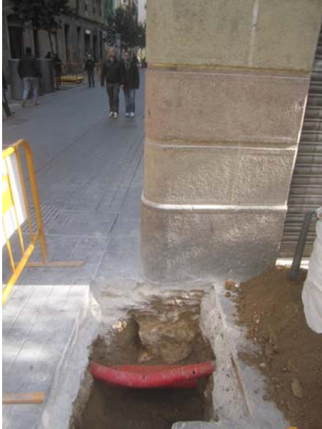
1. Ubicació sondeig 1, amb el mur UE 4 aprofitat com a fonamentació de la finca actual.
