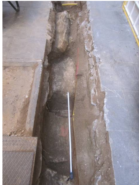
20. clavegueró UE 10 i canalització UE 9.
