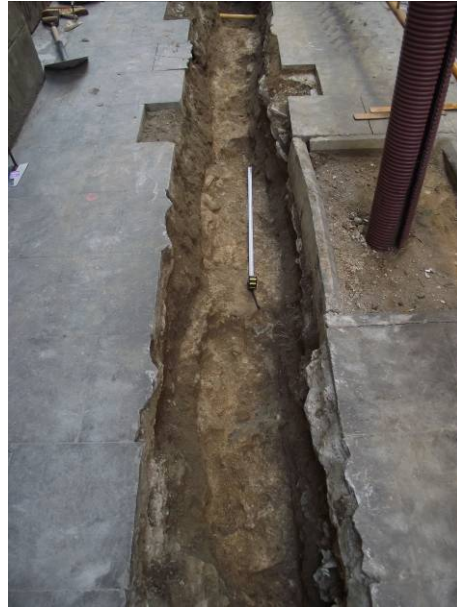
18. Mur UE 5 davant la finca núm. 21b-23.
