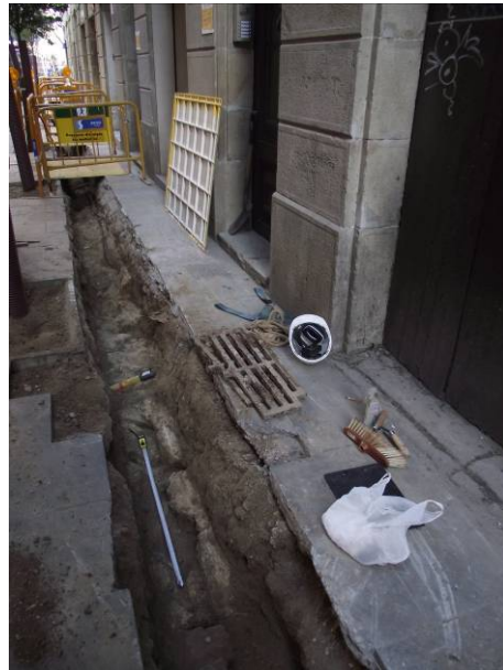
16. Mur UE 5 front la finca núm. 19.
