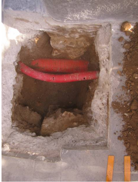
Mur UE 4 seccionat per serveis actuals
